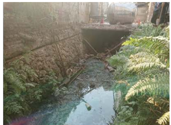
圖 C：建興國中地下停車場入口圍牆下方硃砧石溝體
