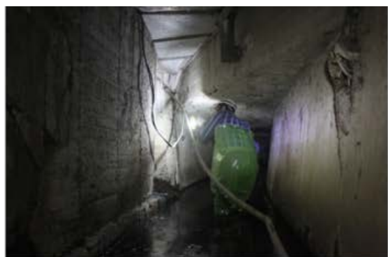
圖 G：台水六區處之水泥箱涵
