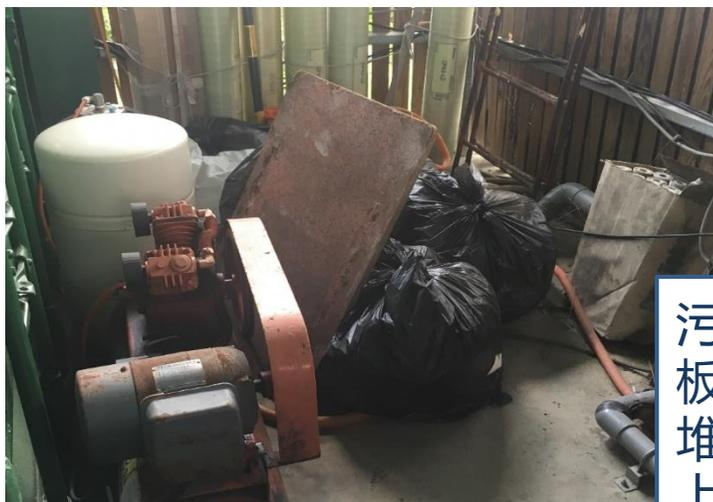
污泥貯池上方蓋板現況，需移除堆置物方可增設上澄液抽水機
