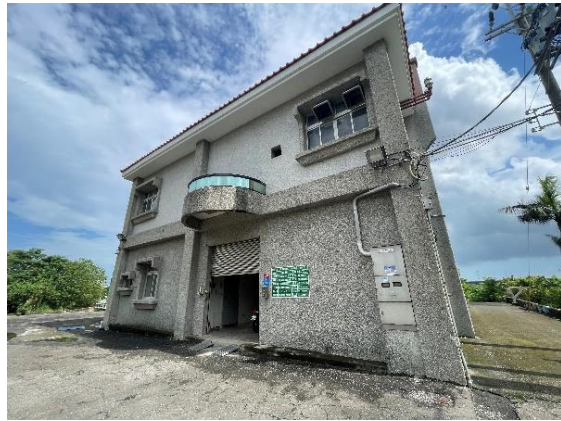
棲地 1：抽水站體周邊環境 日期：112 年 8 月 9 日 位置：抽水站體
