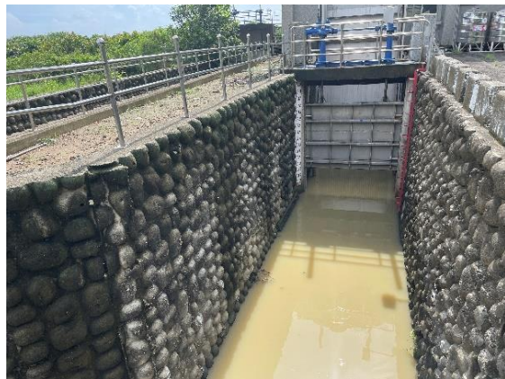
棲地 3：周邊引道 日期：112 年 8 月 9 日 位置：抽水站引道
