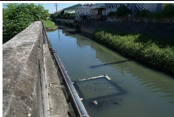
棲地 4：排水路護岸 日期：113 年 7 月 3 日 位置：三爺溪排水
