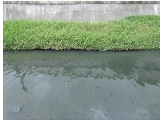
照片：三爺溪護岸基腳濱溪植被生長良好
