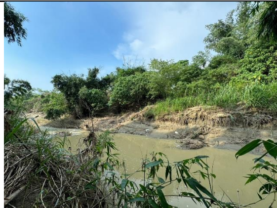
拍照日期：113 年 8 月 23 日 拍照位置：渡頭溪排水 概述說明：土坡護岸濱溪植被生長良好
