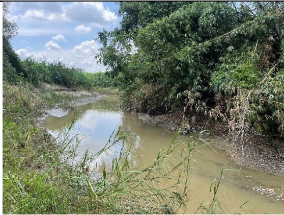
拍照日期：114 年 7 月 17 日 拍照位置：渡頭溪排水 概述說明：渠道周邊有小片竹林
