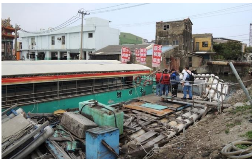
觀光船上下船設施破舊，安全堪慮
