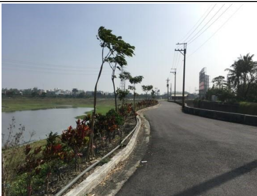
A. 滯洪池環湖道路現況
