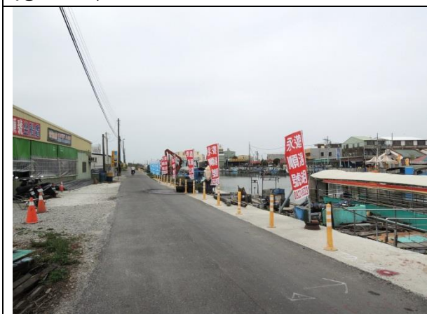
泊區南側無足夠空間施作階梯型式之護岸
