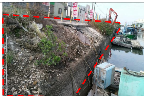
現況護岸殘破，且廢棄物、蚵殼堆置，缺乏安全、美觀、功能性
