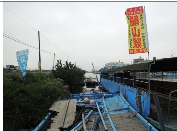
私人業者私自搭設之簡陋上下設施，安全性堪慮
