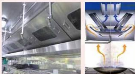
圖 3-3 水洗油煙罩示意圖
