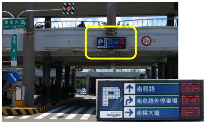
圖 27、LED 數位車位導引顯示器
