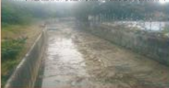
105年龜重溪河道清淤工程完工後照片
