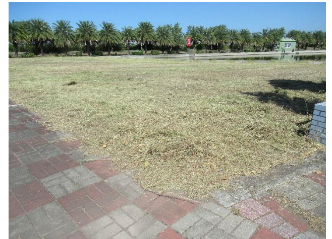
納骨堂周邊樹木及雜草清除計畫施工中、後
