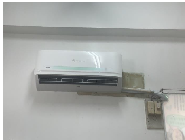
納骨堂原管理室裝設冷氣機計畫
