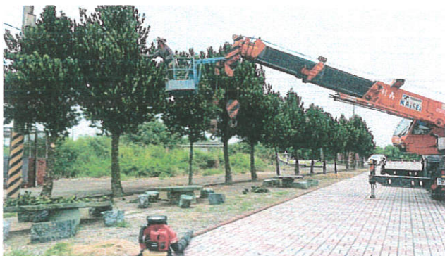
將軍區納骨堂周邊樹木修剪及便道兩側雜草清除計畫施工前
