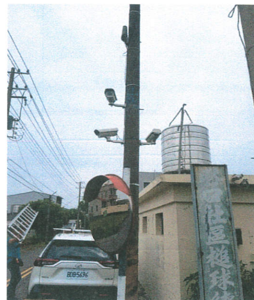
108 年巷埔里(仁和)南 18 線入庄設置 監視器施工後
