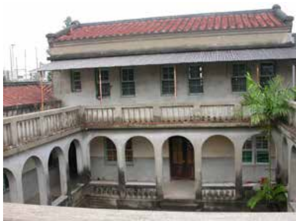
正在等待整修的遂園、遂生醫院
