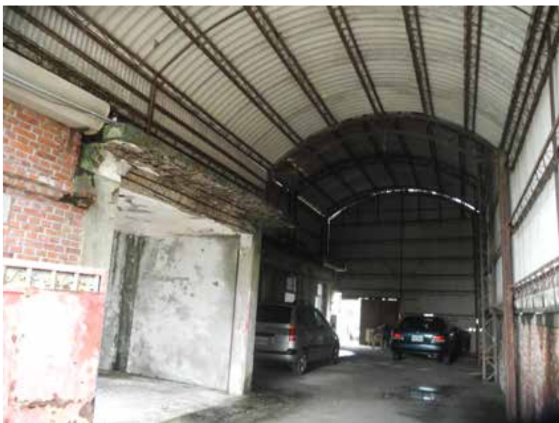
廠棚構造，可謂綜合清末、民初及現代三期之小型工廠建築。
