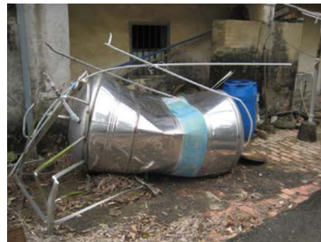
楠坑里 11 鄰草埔坪 18 號林水珍水塔損壞
