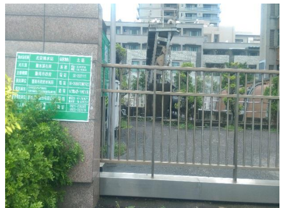
照片 6：北安抽水站
