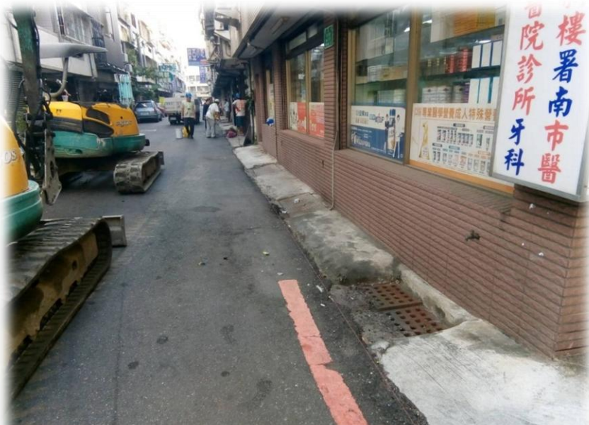
南園街109巷施工中
