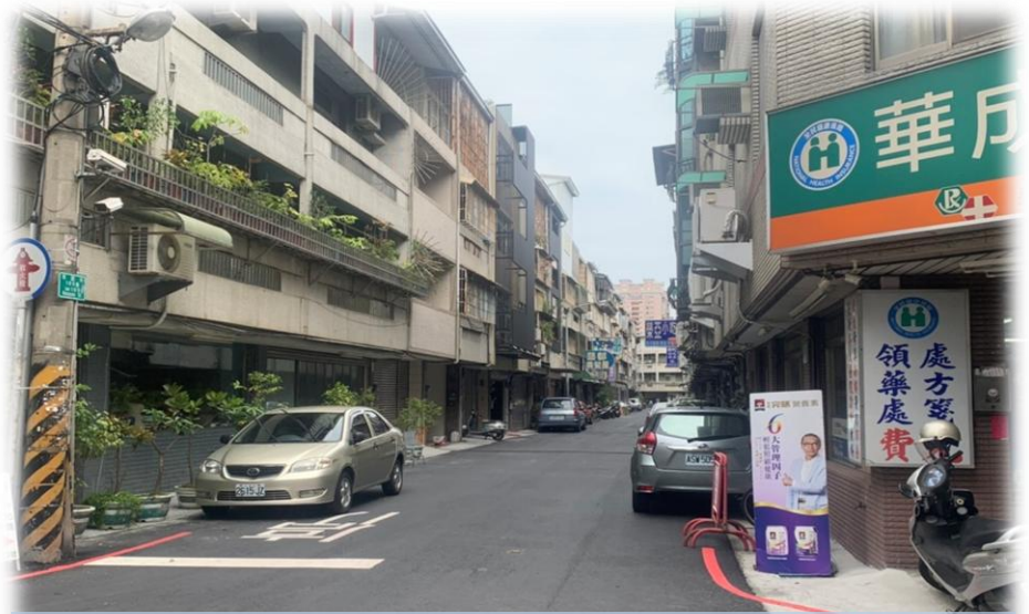
南園街109巷排水溝改善完成
