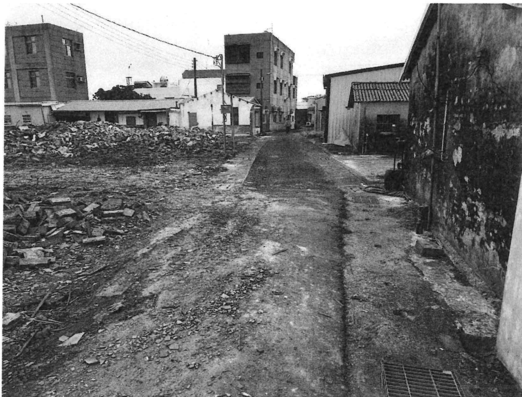
下營區大屯寮段537-28等道路照片
